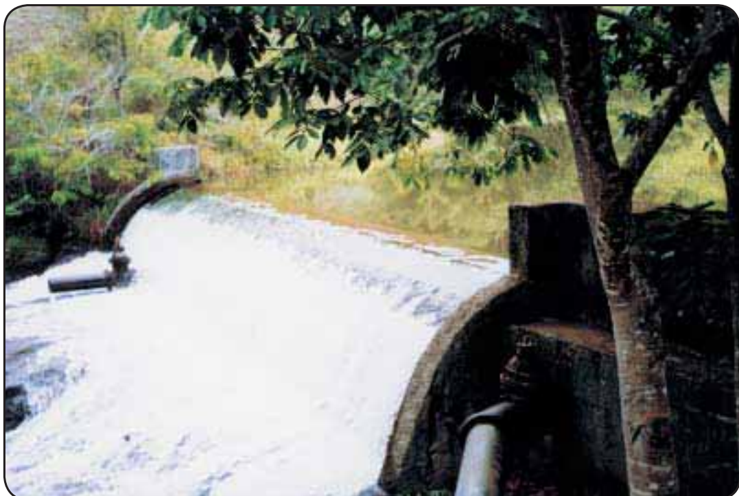
Foto 1 - Tomada direta com barragem de nível
